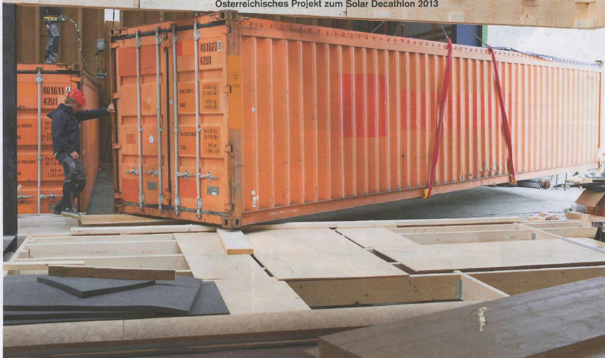
Der österreichische Beitrag zum Solardecathlon 2013 ist bereit für die lange Reise nach Kalifornien: L.I.S.I. – „Living Inspired by Sustainable Innovation“, ein energieeffizientes, kompaktes und vielseitig einsetzbares Holzhaus. Foto: DI G. Pils
